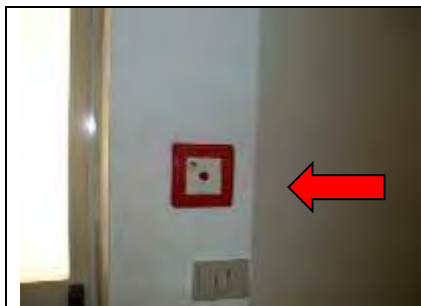
Dispositivi d'intercettazione dell'energia elettrica installato in prossimità dell'uscita di sicurezza che immette in via di Maggio
